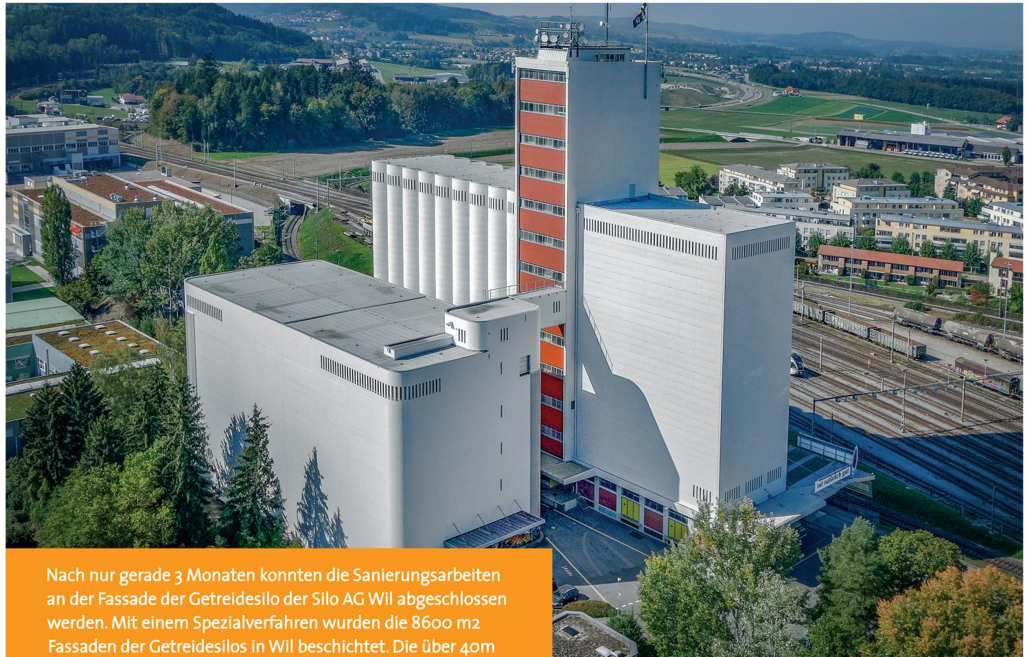
Nach nur gerade 3 Monaten konnten die Sanierungsarbeiten an der Fassade der Getreidesilo der Silo AG Wil abgeschlossen werden. Mit einem Spezialverfahren wurden die 8600 m<sup>2</sup> Fassaden der Getreidesilos in Wil beschichtet. Die über 40m respektive 60m hohen Gebäude wurden gerüstlos mit zwei Schwebegerüsten saniert. Ausführung Frühling bis Sommer 2018
